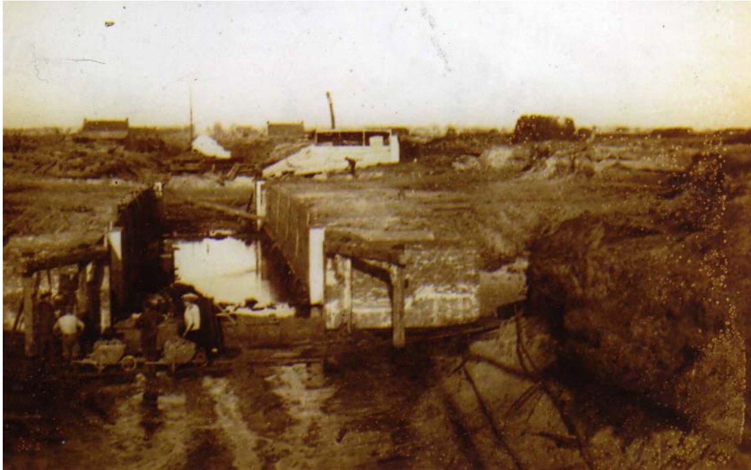
Foto bouw sluis in het Eerste Kruisdiep 1916.
